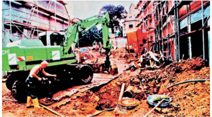
Kanalbauarbeiten bei der Errichtung der „Kleinen Ortsumgehung“ (ehem. Köhlergässchen) im Jahr 1997.
