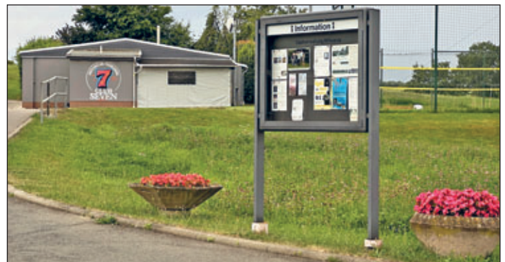
Die Außenfassade des Jugendclubs in Frankenau wurde mit Hilfe des Regionalbudgets saniert – inklusive Graffiti. (Foto: Ingo Gringer)
