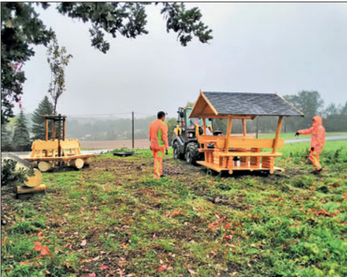
Der Bauhof unterstützt den Waldheimer Verschönerungsverein mit dem Aufstellen eines Sitzunterstandes mit Dach, einer Baumbank und eines Radständers am Radweg Waldheim-Rochlitz.
