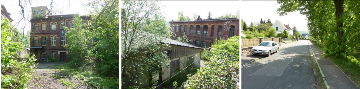
Abbildung 32: Güterbahnhofstraße 1 und Luise-Romstedt-Straße
