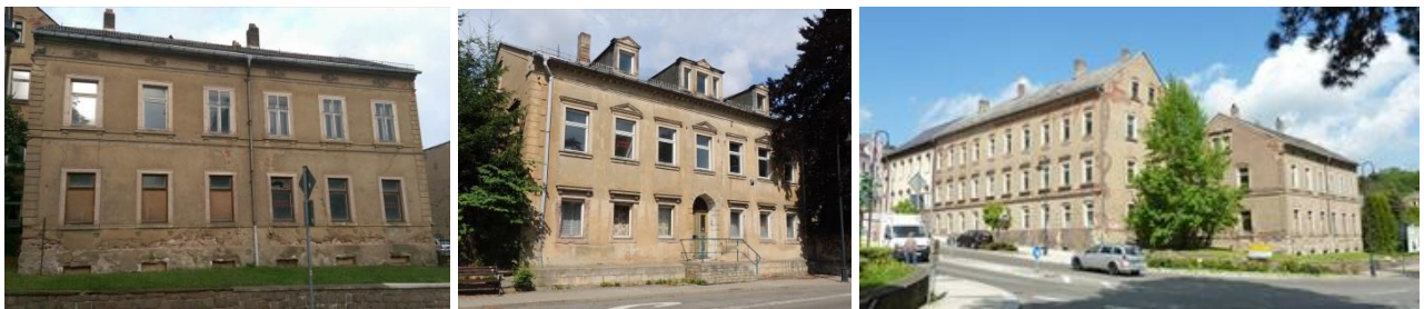
Abbildung 37: Mittweidaer Straße 25 & 27 und Ecke zur Härtelstraße
