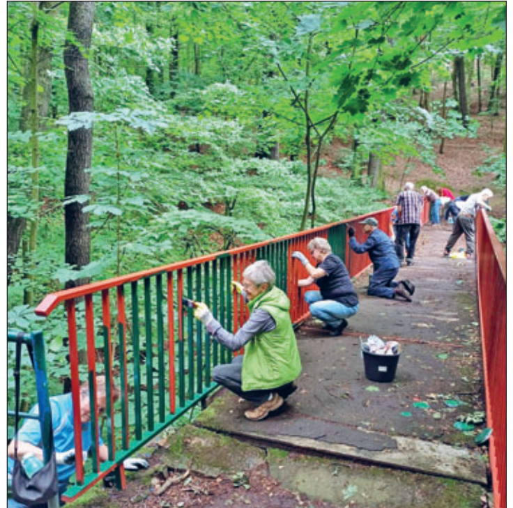
Das Geländer der Wolfskehlen-Brücke erhält den zweiten Anstrich
