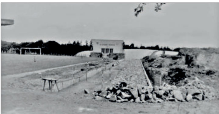
Diese Aufnahme zeigt den Baufortschritt im Jahr 1963.
